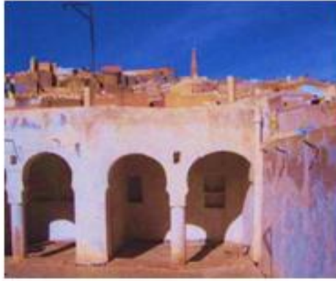
الصورة 5: سطح مسكن بمدينة عليكة.
